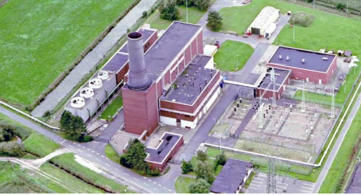
Şekil 8 The Huntorf plant [9]
