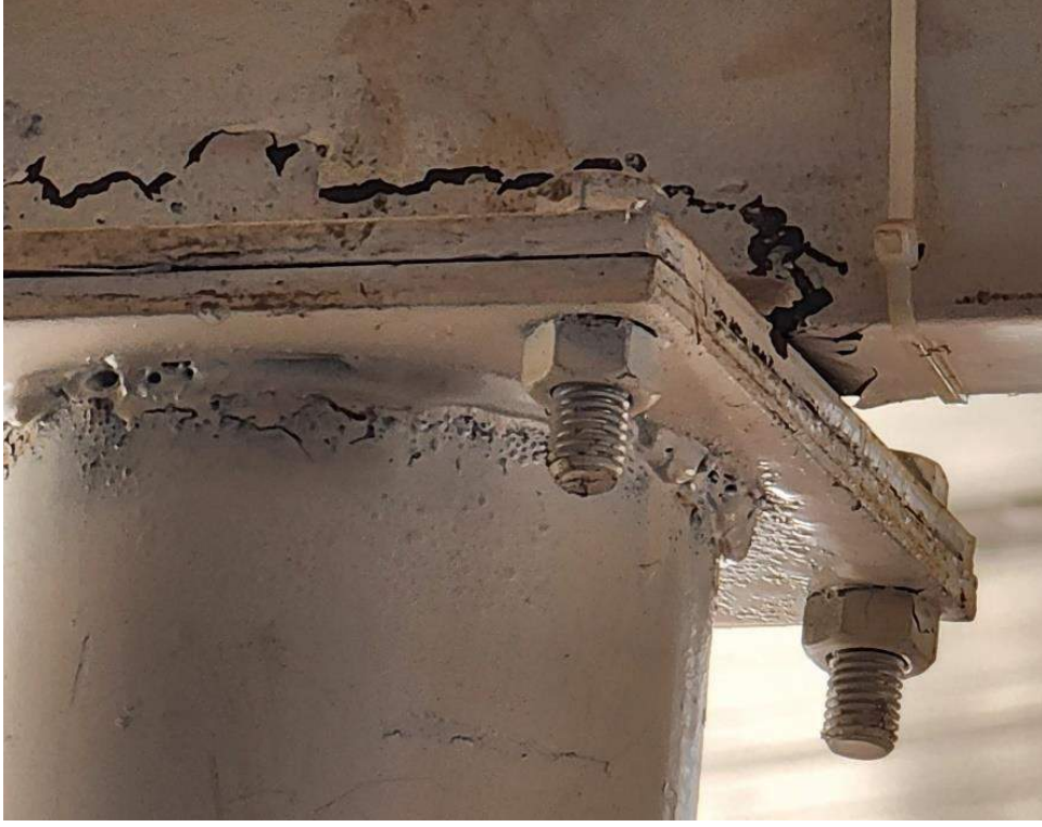
Şekil.4 Kaynakta Gözenekler, Yanma Oluđu, Sıçramalar, Kalıntılar, Çarpılmalar
