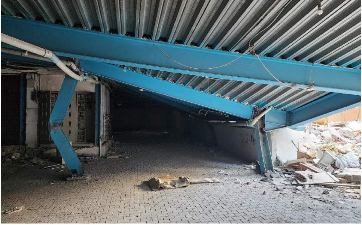
Şekil.3 Deprem Etkisinde Kritik Elemanlarda Hasar Oluşumu
