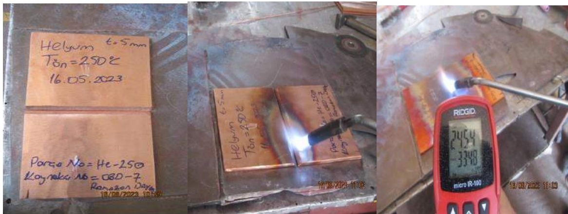
Resim 1 : Kaynak öncesi ve ön ısıtma esnasındaki uygulama
