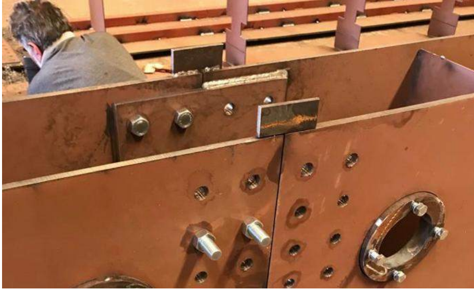
Şekil 8. Bindirme tip kaynaklı birleştirme yöntemleri optimum kenar yaklaşım kaynaklı imalat uygulaması.
