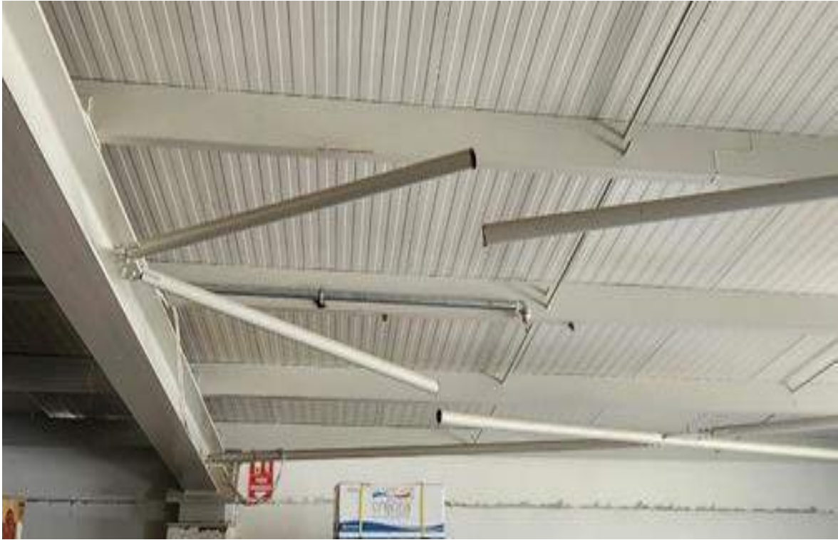
Şekil.5 Boru Ek Kaynağı Yetersiz Ergime ve Nüfuziyet
