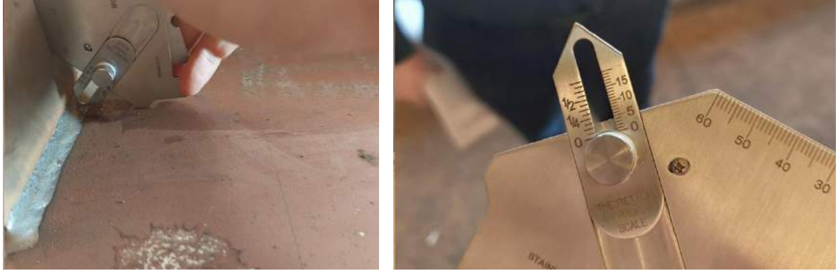
Şekil 2. Dışa kavisli köşe kaynağı (90°) dikişi kaynaklı imalat saha ölçüm ve kontrolleri (a=4.5 mm).
