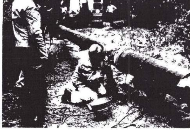
Şekil 1.3 12” (inç) çaplı boru için köprü içermeyen kelepçe [3].
