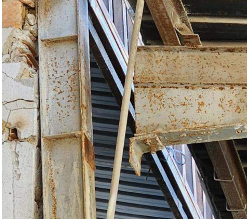
Şekil.6 Kolon-Kiriş Birleşimi Yetersiz Ergime ve Nüfuziyet
