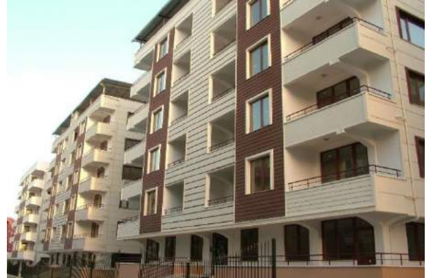
Çelik Apartmanları – Antakya (Depremden önce)
