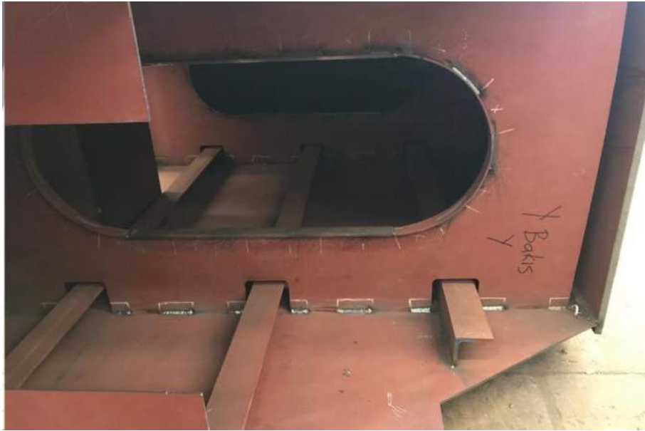
Şekil 4. Köprü vinç kirişi kaynaklı imalat projelerinde optimum metod kaynaklarının konumlarının belirlenmesi ve diyaframlarda metod köşe kaynağı uygulaması (BVS CRANES).
