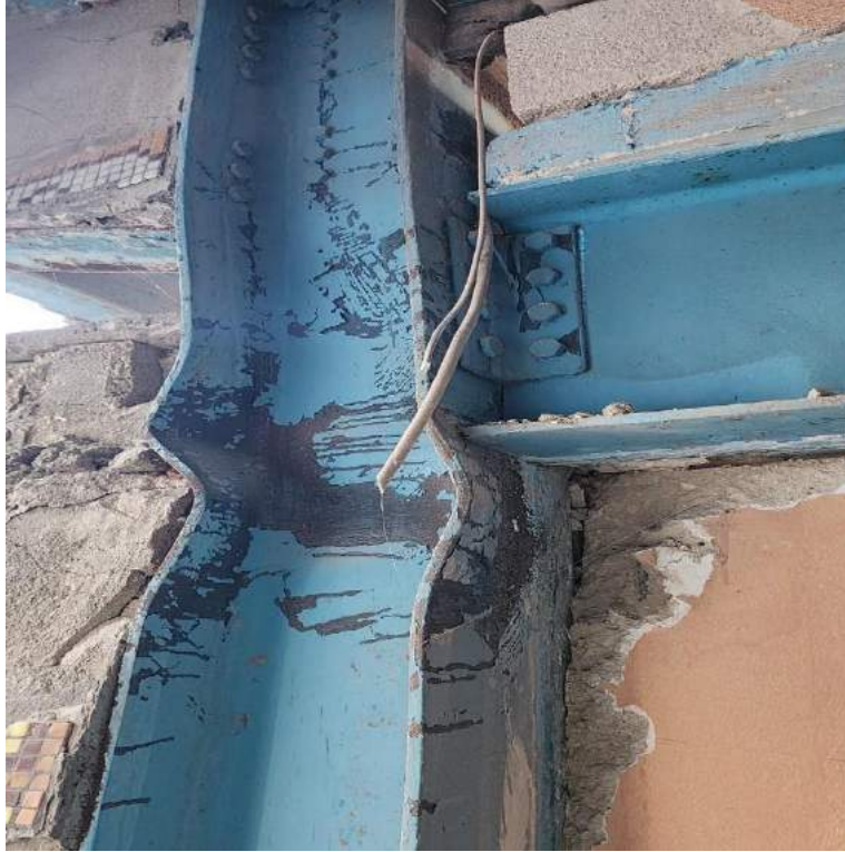
Şekil.2 Çelik Yapıda Tasarımsal Birleşim Detayı Hatası
